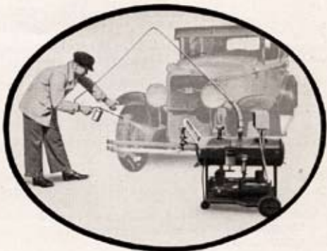
Abb. 8. Beim Abblasen des Fahrgestells mit Petroleum.
