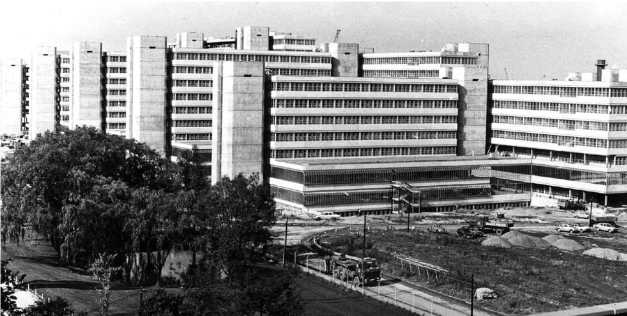
Um 1970: Die Universität Bielefeld im Bau.
