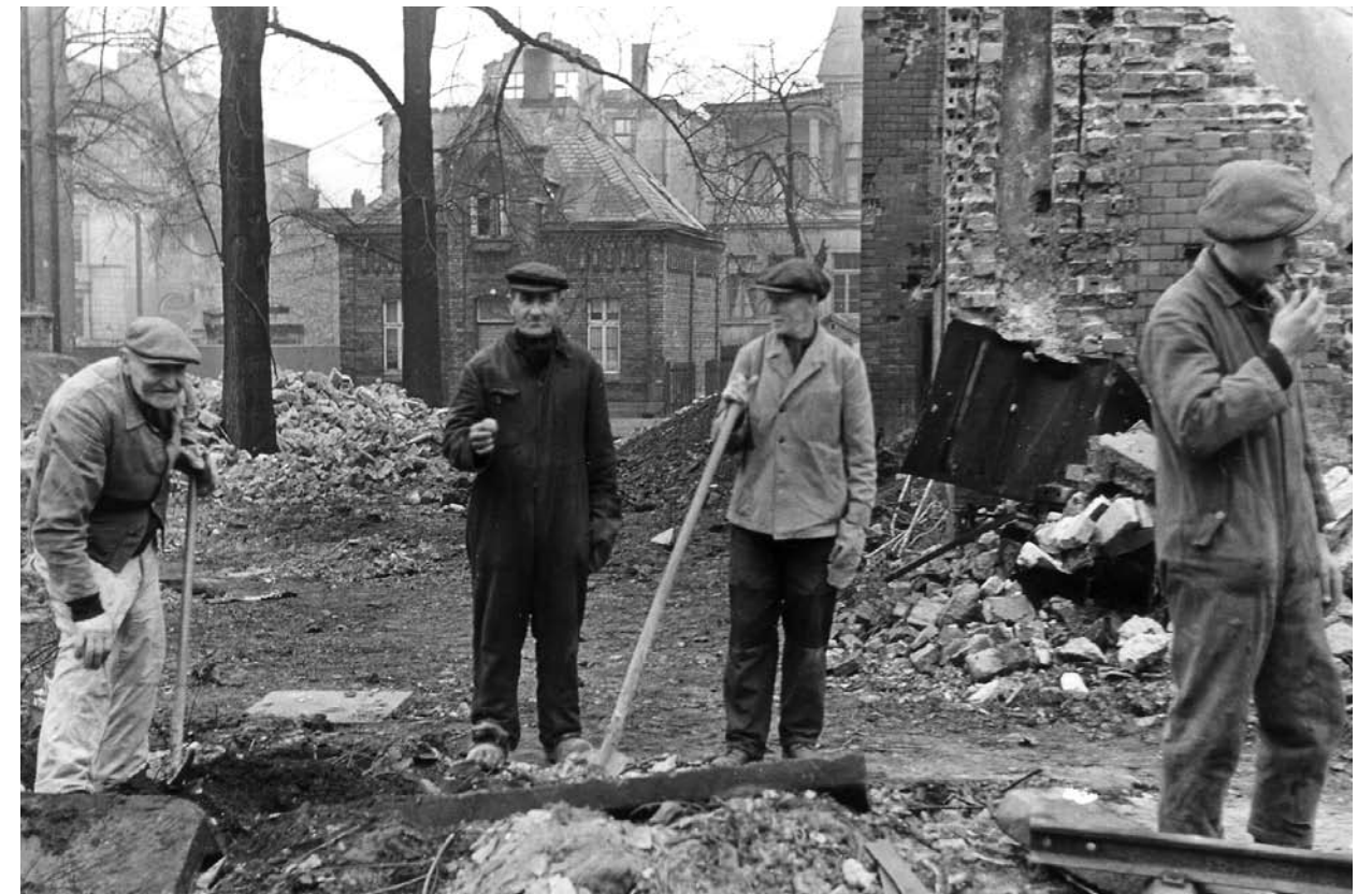
1947: Alle Mann im Einsatz. Trümmerräumung in der Bielefelder Innenstadt.
