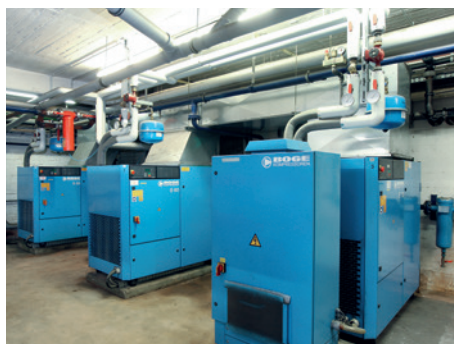
Twee oliegesmeerde S 60-schroefcompressoren en een frequentieregelde SF 61-compressor leveren de vereiste perslucht
