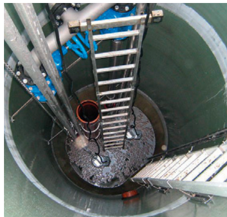
Riolschacht met diverse drukdrainageinstallaties
