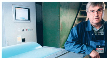
Compresores de tornillo de BOGE – utilizados en Bürck desde 1991
