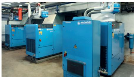
**Due compressori a vite a iniezione d'olio della serie S 60 e un compressore con regolatore della frequenza della serie SF 61 forniscono l'aria compressa necessaria.**
