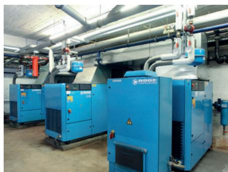
**Zwei öleingespritzte Schraubenkompressoren S 60 und ein frequenzgeregelter Kompressor der Baureihe SF 61 sichern die Druckluftversorgung.**
