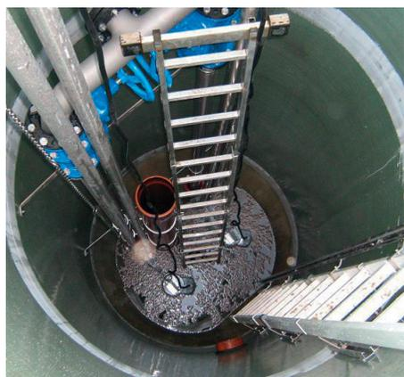
Pozo de aguas residuales con diferentes instalaciones para el desagüe a presión.
